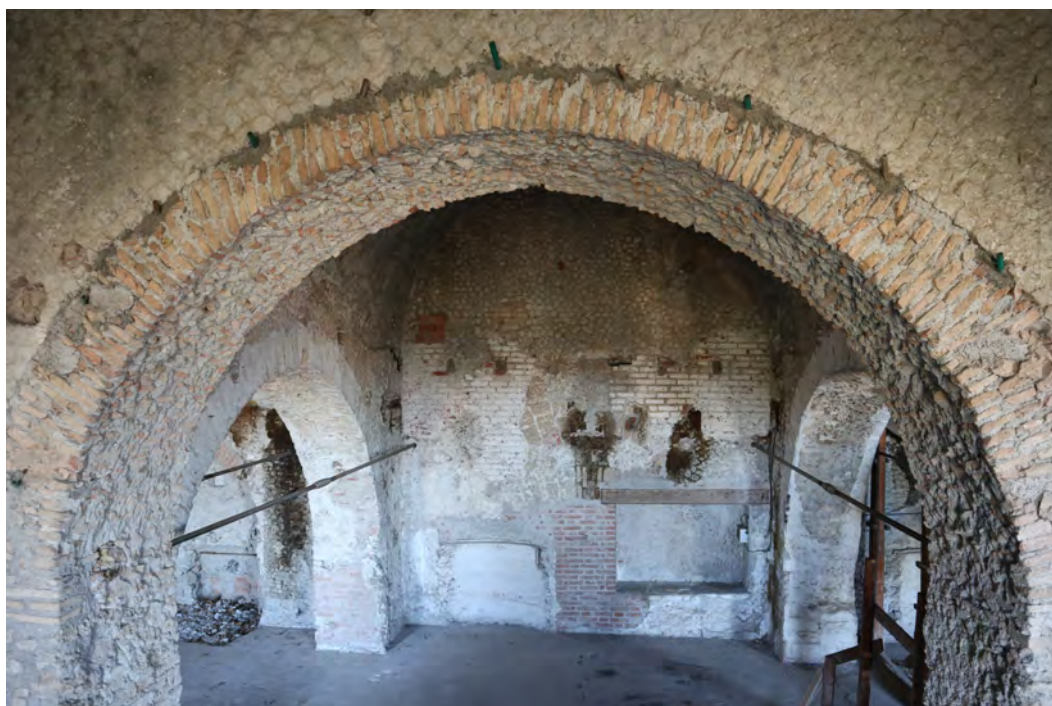
Figura 4.13. Tubi in gomma per iniezioni di malta nella ghiera dell'arco moderno, realizzato in sostituzione del muro che divideva originariamente la galleria di padiglioni e l'ambiente 28.
