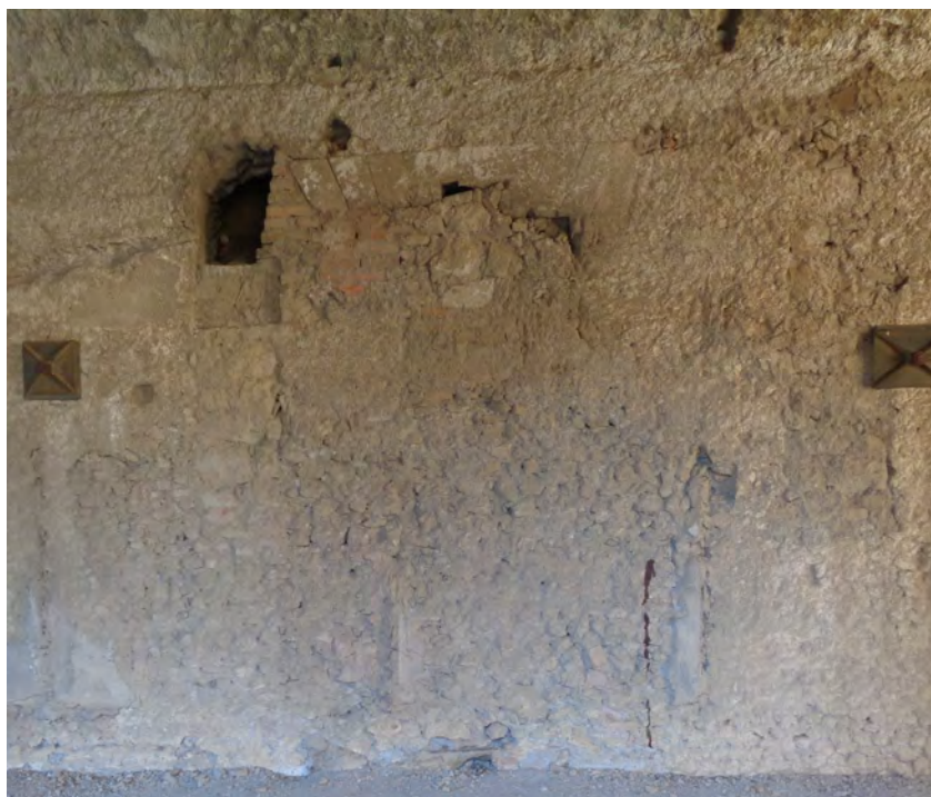
Figura 4.7. Resti dell'apertura che doveva collegare l'ambiente 23 con il triportico dell'area sacra, successivamente tamponato. Si nota in alto la piattabanda in pietra.
