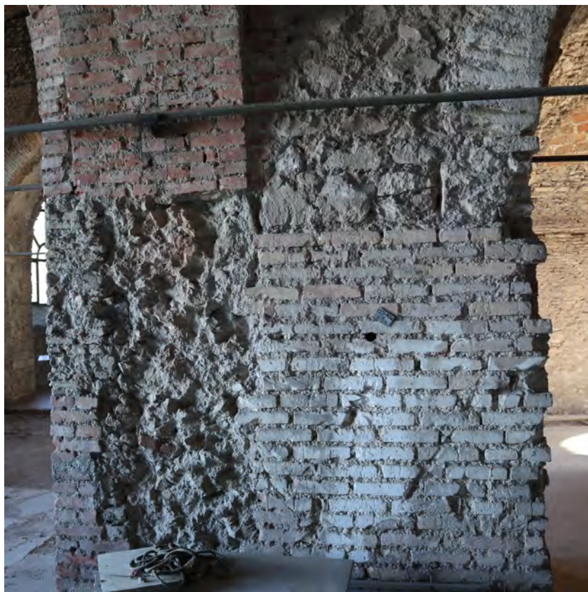
Figura 4.6. Traccia del muro che separava l'ambiente 23 dalla galleria di padiglioni.
