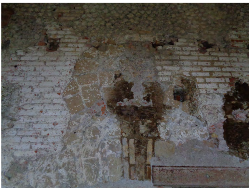
Figura 4.12. Tracce di due archi nel muro moderno dell'ambiente 28.
