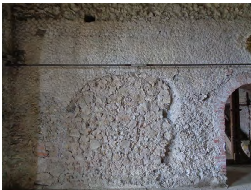
Figura 4.8. Tamponatura nel muro di fondo dell'ambiente 33, ripresa dall'ambiente 37 esterno alla chiesa.
