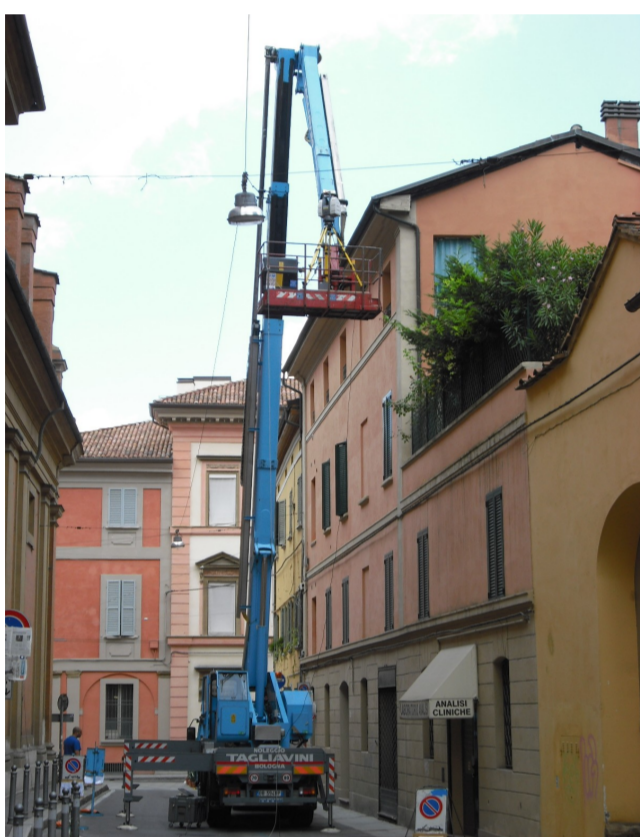
Scansione dell'Esterno della Basilica
